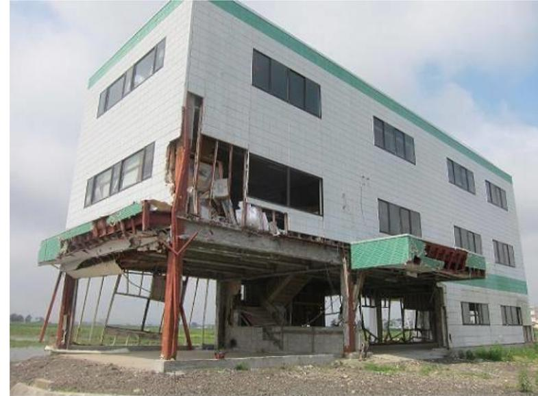
Condiciones de las edificaciones con columnas tipo cajón con conexiones de marco rígido después del tsunami.
