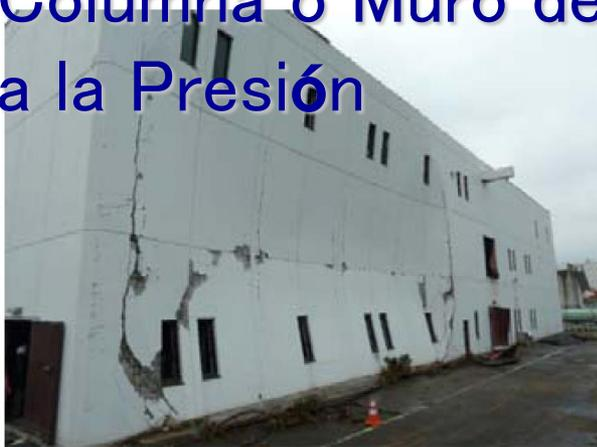
Para evitar la flexión o cizallamiento, la resistencia a la rotura de las partes estructurales debe ser más alta que la de tsunami.
