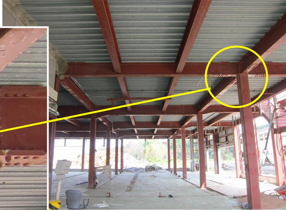
El marco principal de acero, las columnas tipo cajón con vigas, y las conexiones de marco rígido NO presentaron daños
